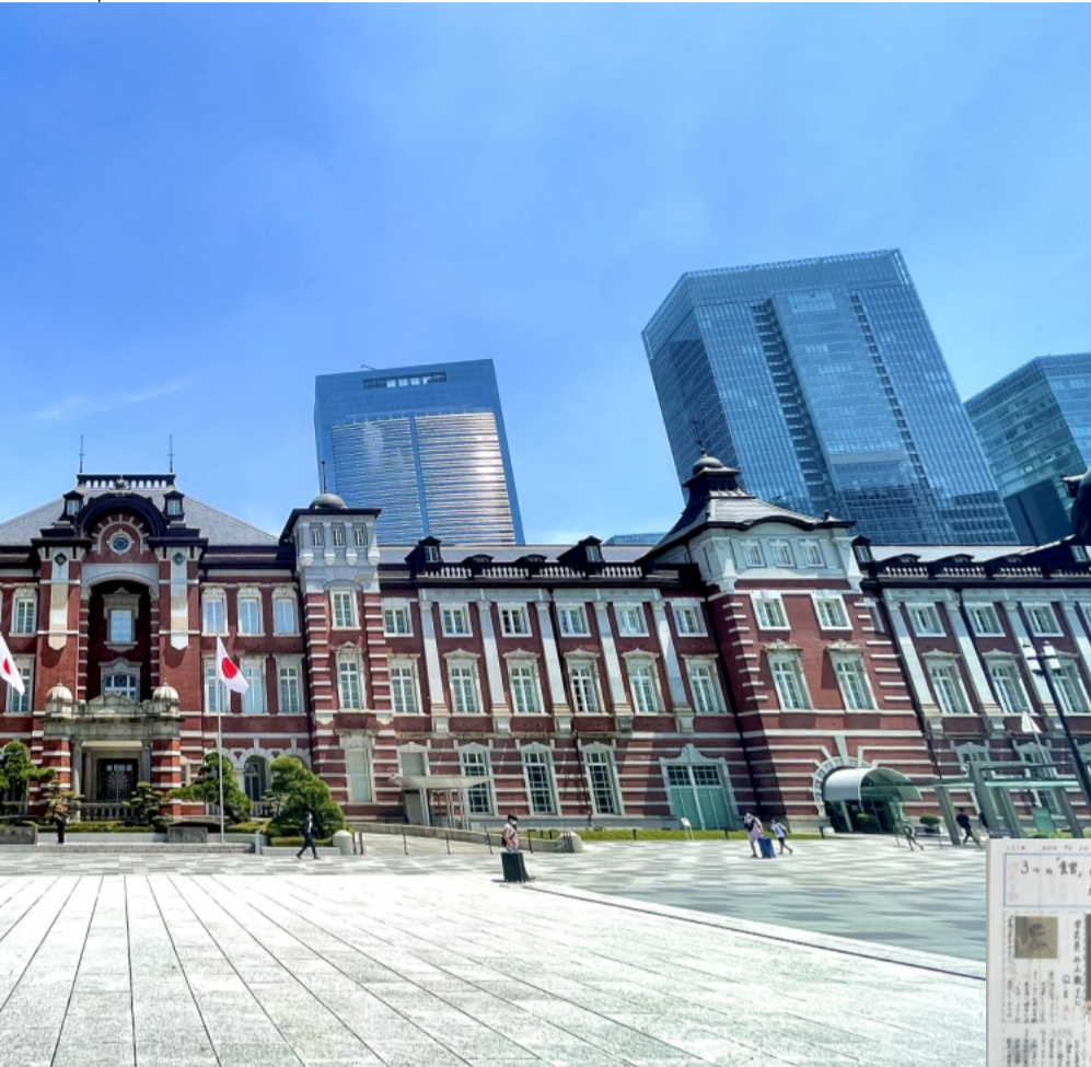
↑東京のシンボル「東京駅丸の内駅舎」を正面から 撮影：副部長(川)
