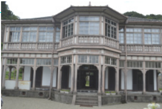
↑正面から見た異人館 真ん中の2階はかつてベランダであった。
